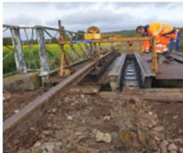
Pérennisation d'un Pont Rail par les Taupiers sur notre ligne
